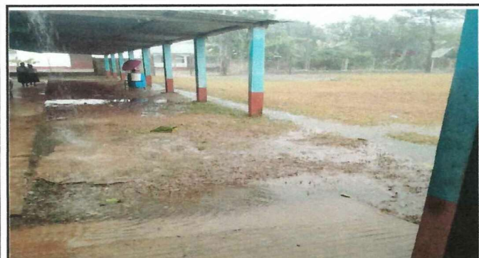
Foto 3: Sustituir por cuneta, ya que en época de invierno nos llenamos de agua tanto dentro como fuera de las aulas.
