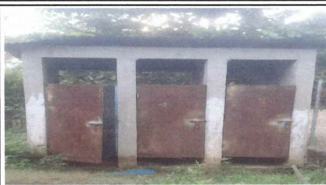
Foto 2: remodelacion de los sanitarios, puertas de los baños
